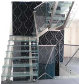
Trappa med steg i mönstrat glas, vång i rostfritt stål. Räcke i glas med handledare i rostfritt.
